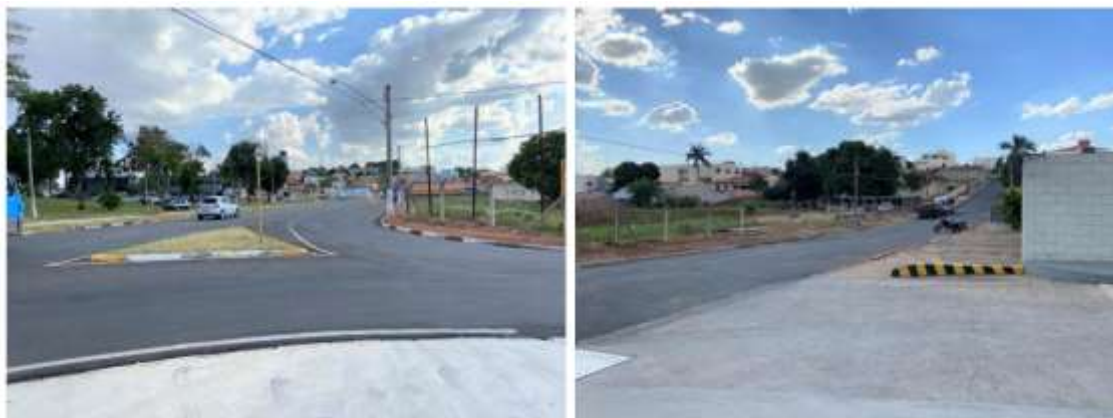
Figura 8: Imagem à esquerda vista da Avenida dos Trabalhadores, à direita vista da rua Santo Antônio e Lateral do terreno do projeto.
