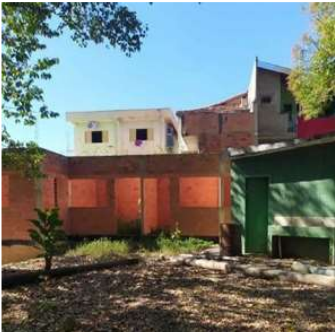
Figura 12: Vista da construção do prédio dos escoteiros que está embargada, e à direita, do prédio em que há sanitários e bebedouros..
