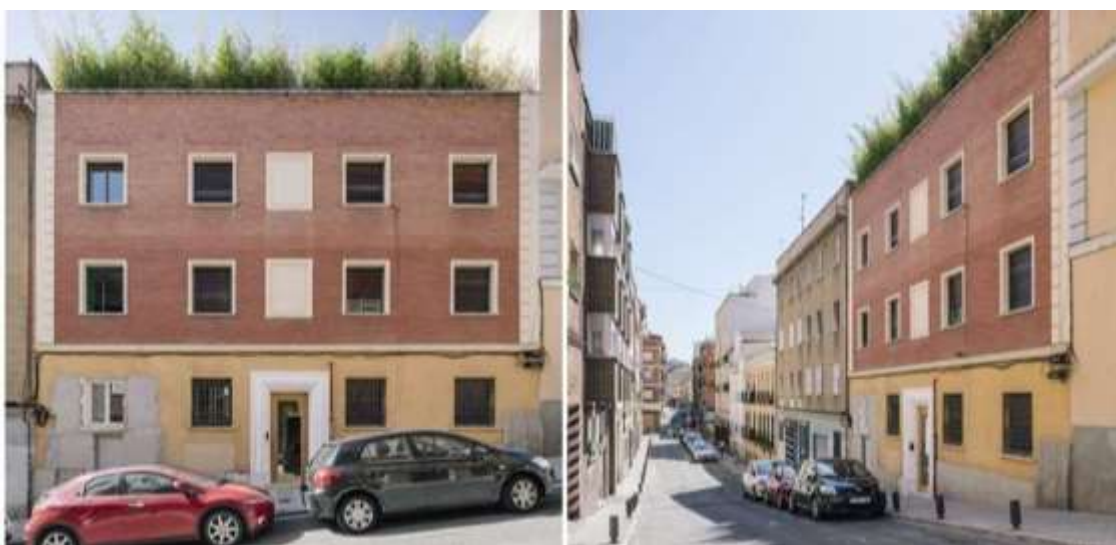
Figura 7: Fachadas do edifício.
