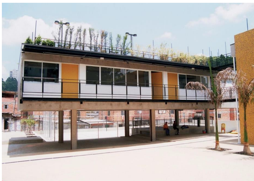
Figura 1: Edifício Sede Projeto Viver
