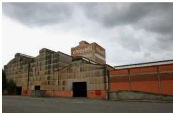
Figura 6: Visão dos fundos da antiga Cerâmica Chiarelli
