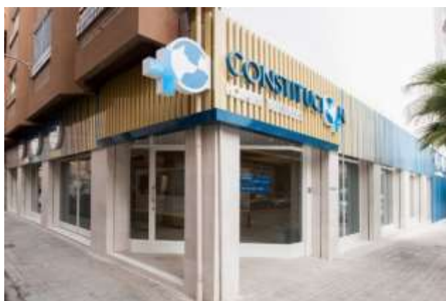
Figura 7: Fachada do hospital veterinário Constitución.
